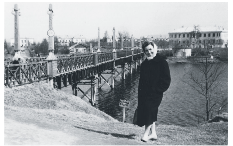
Мост через реку Сьткне.
