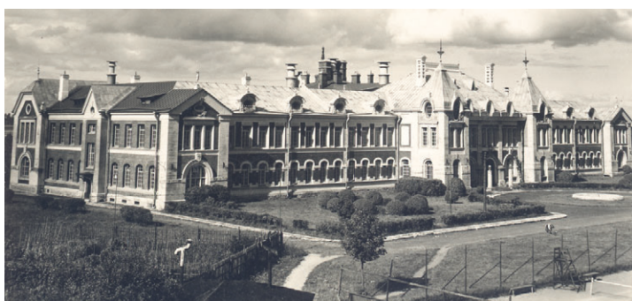
Больница Кренгольмской мануфактуры. Больница была рассчитана на 200 мест и отлично технически оборудована. В 1922 году была закрыта. Во время второй мировой войны здание пострадало. После восстановления в 1969 году начала работать как городская больница. О. Хайдак.
